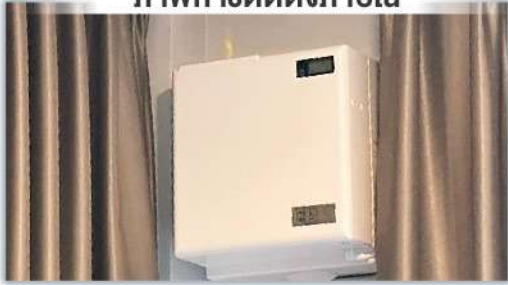
ภาพการติดตั้งภายใน
