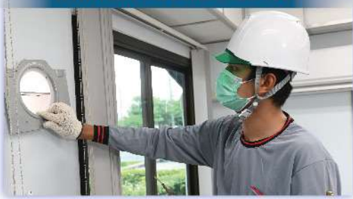
ภาพการเจาะผนังและเดินสายไฟ
