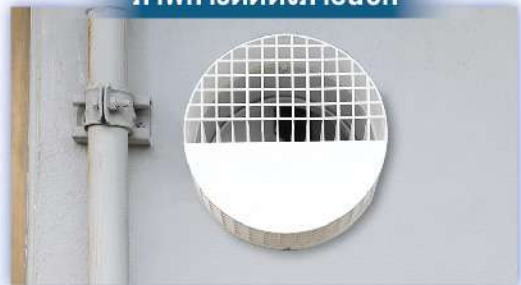
ภาพการติดตั้งภายนอก
