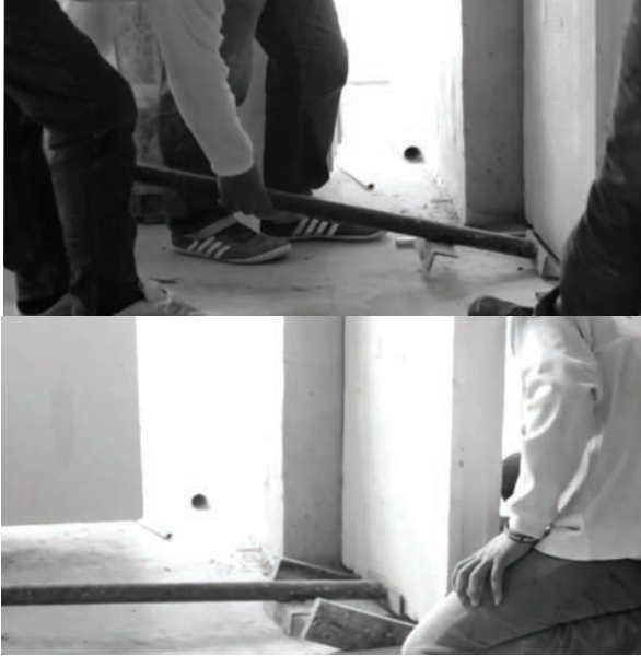
6. จัดแผ่นผนัง Q-CON Wall Panel จนชนกับพื้นโครงสร้างด้วยเหล็กจัดแผ่น แล้วสอดรองรับด้วยลิ่มไม้
