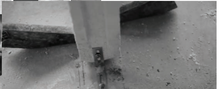
7. ยึดเหล็กจากติดกับพื้นโครงสร้างด้วยพุก และยิงยึดสกรูเกลียวปลายสว่านเข้าด้านข้างแผ่นผนัง Q-CON Wall Panel ทั้งด้านบนและล่าง
