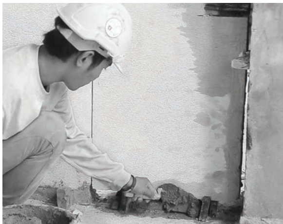
11. อุดด้านล่างของแผ่นผนัง Q-CON Wall Panel ด้วยปูนทราย
