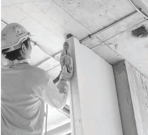
9. ติดตั้งแผ่นผนัง Q-CON Wall Panel ต่อๆ ไป จนถึงแผ่นสุดท้ายที่จะจับกับเสาโครงสร้าง
