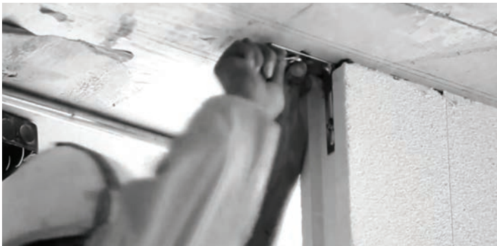
10. ติดตั้งแผ่นผนัง Q-CON Wall Panel แผ่นสุดท้ายเข้ากับโครงสร้างแล้วยึดติดด้วยพุก
