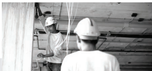
1. ทำความสะอาดก่อนหาแนวและระยะการติดตั้งจากแบบ และกำหนดเส้นแนว ด้วยปากกาดำเพื่อเป็นแนวที่จะติดตั้ง
