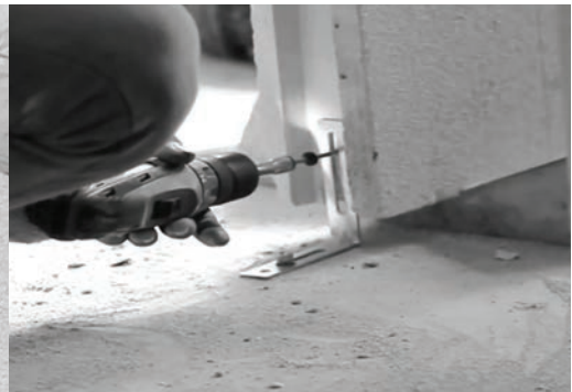
10. ติดตั้งแผ่นผนัง Q-CON Wall Panel แผ่นสุดท้ายเข้ากับโครงสร้างแล้วยึดติดด้วยพุก
