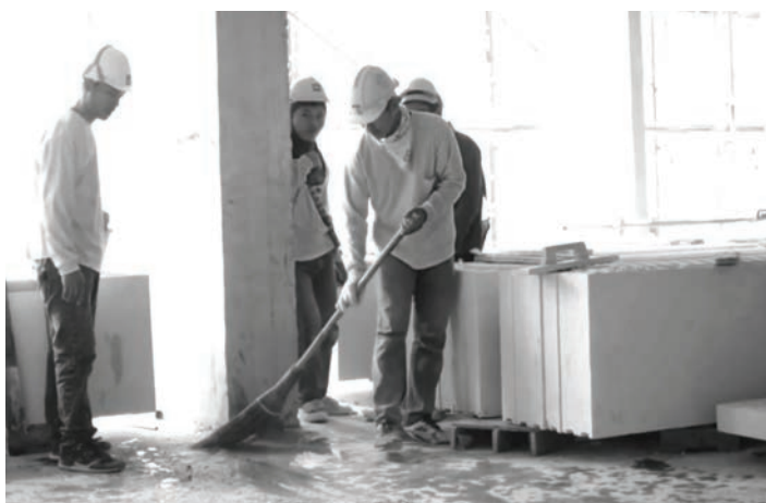
1. ทำความสะอาดก่อนหาแนวและระยะการติดตั้งจากแบบ และกำหนดเส้นแนว ด้วยปากกาดำเพื่อเป็นแนวที่จะติดตั้ง
