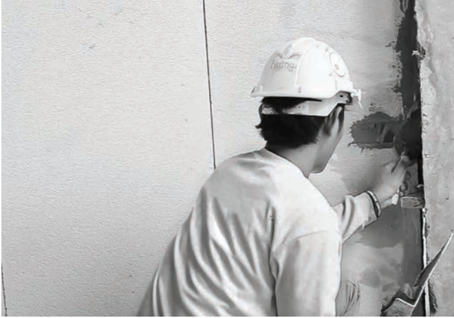
13. เก็บพื้นผิวด้วยปูนฉาบหรือปูน Skim coat
