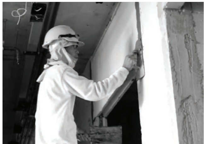
12. เก็บรอยต่อระหว่างแผ่นผนัง Q-CON Wall Panel ชั้นที่ 1 ด้วยปูนก่อ รอแห้งและขัดด้วยกระดาษทราย #400
