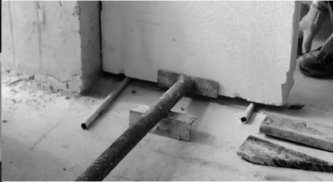
6. จัดแผ่นผนัง Q-CON Wall Panel จนชนกับพื้นโครงสร้างด้วยเหล็กจัดแผ่น แล้วสอดรองรับด้วยลิ่มไม้
