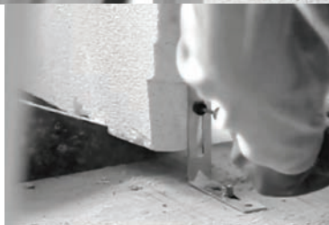
7. ยึดเหล็กจากติดกับพื้นโครงสร้างด้วยพุก และยิงยึดสกรูเกลียวปลายสว่านเข้าด้านข้างแผ่นผนัง Q-CON Wall Panel ทั้งด้านบนและล่าง
