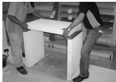
11. ก่ออิฐ Q-CON ปิดด้านหลัง และตกแต่งรอยต่อของเคาน์เตอร์ครัว
