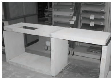
12. ติดตั้งชุดอุปกรณ์ต่างๆ เช่น สีนแกรนิต SINK ชุดบาน SINK เป็นต้น
