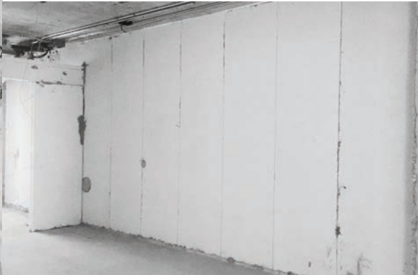
9. ติดตั้งแผ่นผนัง Q-CON Wall Panel ต่อๆ ไป จนถึงแผ่นสุดท้ายที่จะจับกับเสาโครงสร้าง
