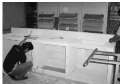
12. ติดตั้งชุดอุปกรณ์ต่างๆ เช่น สีนแกรนิต SINK ชุดบาน SINK เป็นต้น
