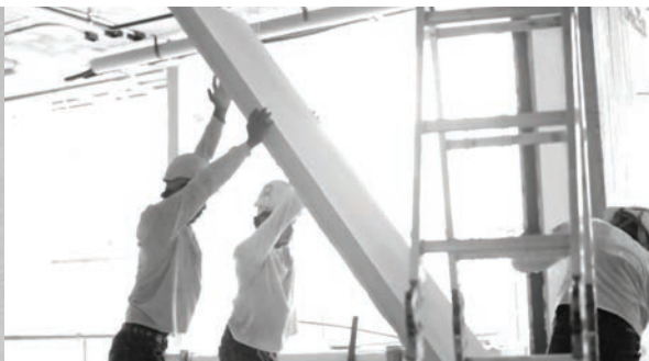
8. ป้ายปูนก่อ Q-CON ที่ข้างแผ่นผนัง Q-CON Wall Panel แผ่นที่ 1 และยกแผ่น Q-CON Wall Panel เข้าติดตั้งต่อไปแล้วทำเหมือนขั้นตอนติดตั้งแผ่นที่ 1
