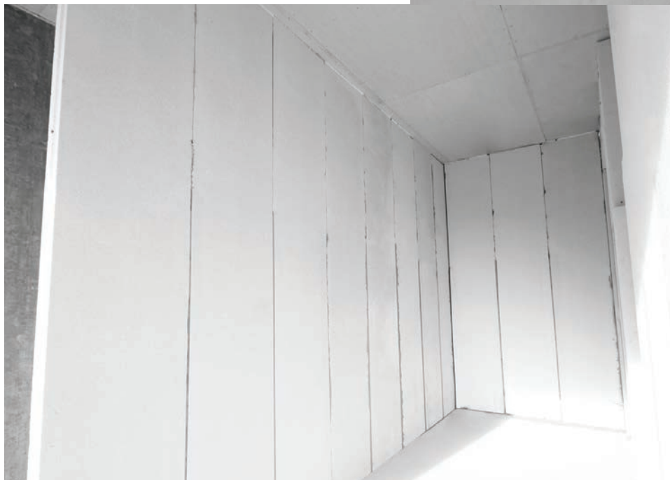
14. ติดตั้งแผ่นผนัง Q-CON Wall Panel แล้วเสร็จ
